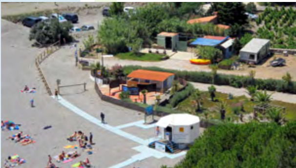
Point d'accueil du sentier sous-marin autonome de Peyrefite (Réserve Naturelle Marine de Cerbère Banyuls - France)
